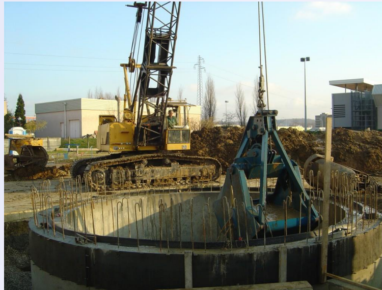
Descente du cuvelage par havage
