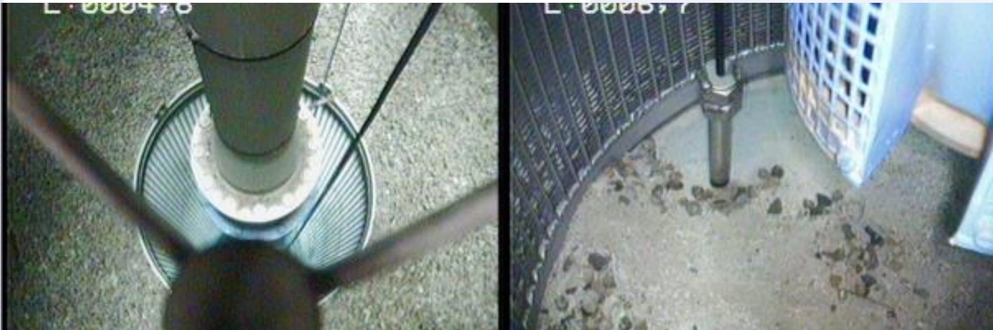
Crépines à fil enroulé et massif additionnel
